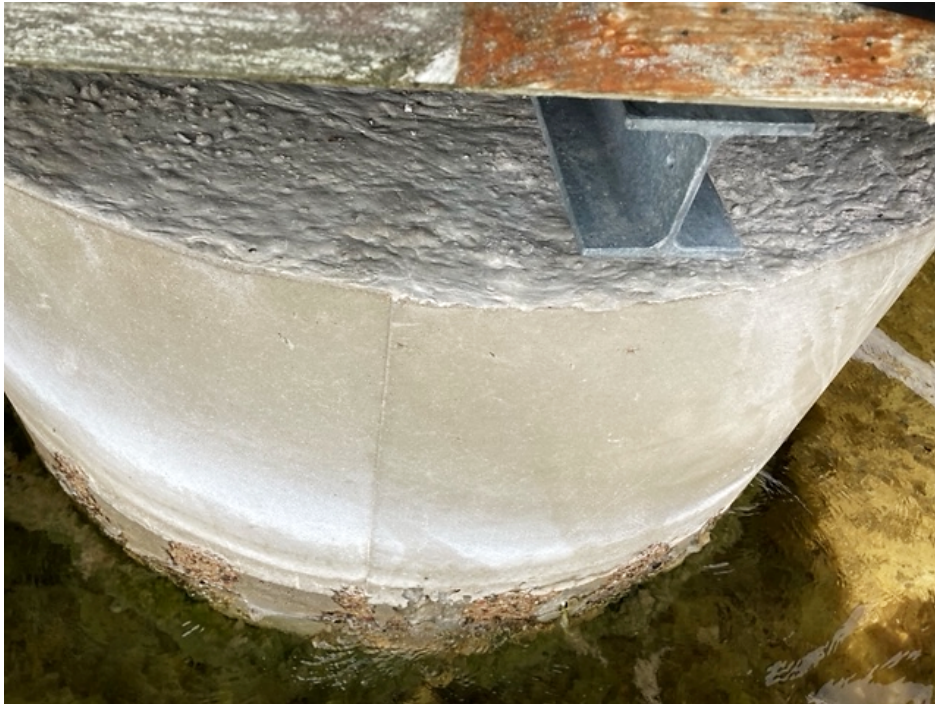
Foto nr. 19 Stöd: 3 – Detaljfoto efter utförd formrivning.
