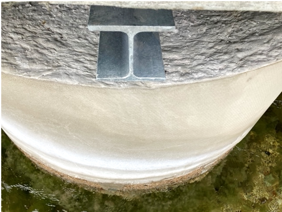
Foto nr. 20 Stöd: 4 – Detaljfoto efter utförd formrivning.
